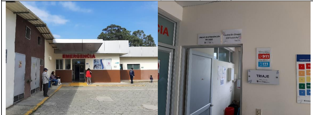
Área de Emergencia y Triage
